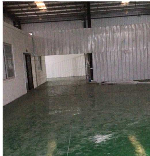
租用厂房现状
