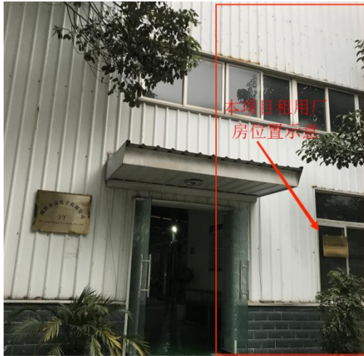
租用厂房现状
