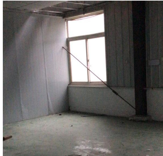
租用厂房现状
