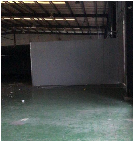
租用厂房现状
